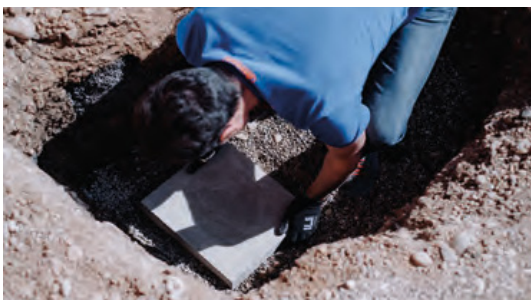
3. Basis-Betonplatte waagrecht ins Niveau einrichten
