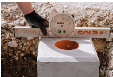
6. Waagrechte Ausrichtung kontrollieren
