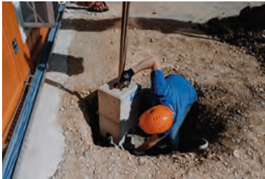
5. Versetzung des Fundaments und Einziehen des Kabels
