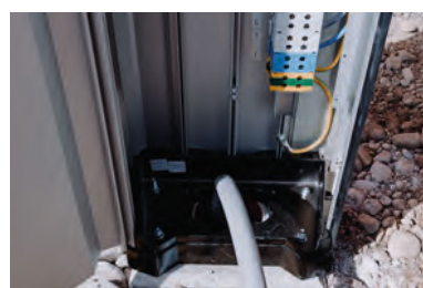
9. Versetzen und Montage der Ladesäule am Fundament
