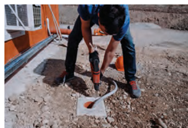
8. Bohrungen für die Montageplatte setzen
