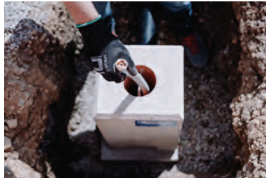
5. Versetzung des Fundaments und Einziehen des Kabels
